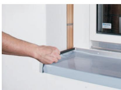
Ablängen des Anschlussprofils U-DA mit Hilfe der Universalschere.
