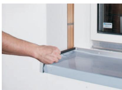
Ablängen des Anschlussprofils U-AL mit Hilfe der Universalschere.
